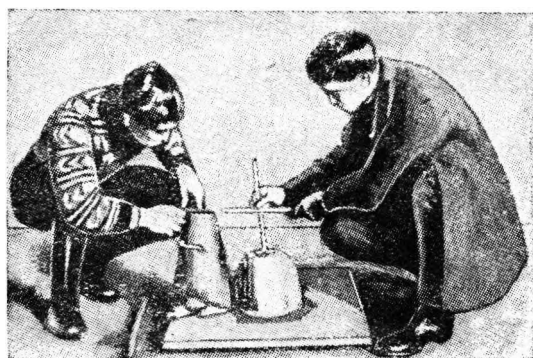
Рис. 19. Измерение осадки конуса.
