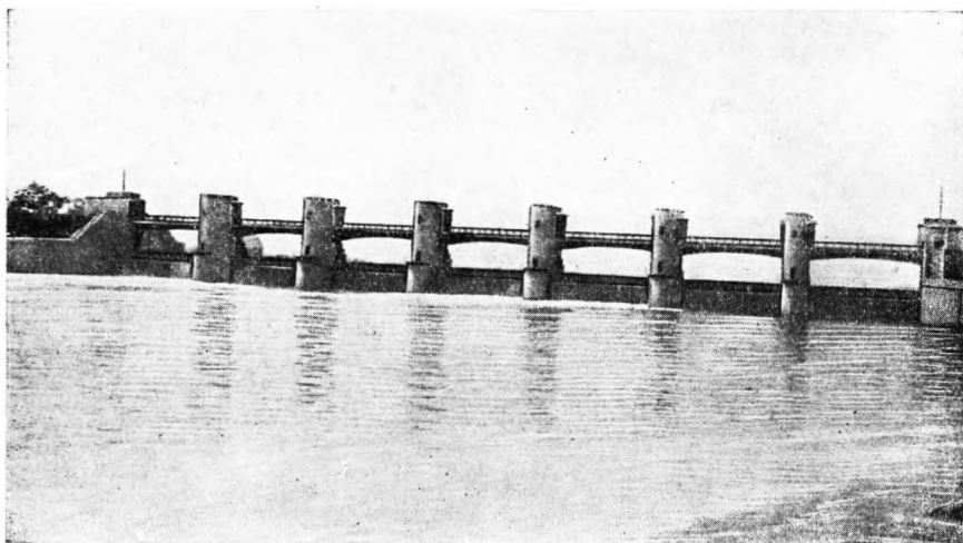
Рис. 120. Плотина на канале Москва—Волга. Вид со стороны верхнего бьефа.
