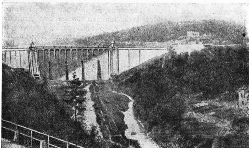
Рис. 35. Плотина на р. Эннепе.
