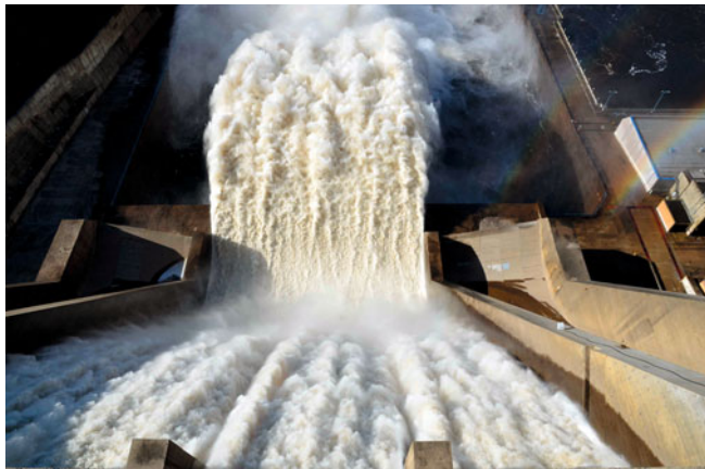
Рис. 7. Насыщение сбросного потока воздухом при работе пролётов № 3 – 6 с открытием их затворов на 1,5 м
