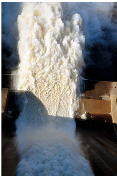
Рис. 3. Расширение струи на цилиндрическом носке-трамплине при работе пролёта № 5 с открытием его затвора на 1,5 м; отм. УВБ = 255,35 м
