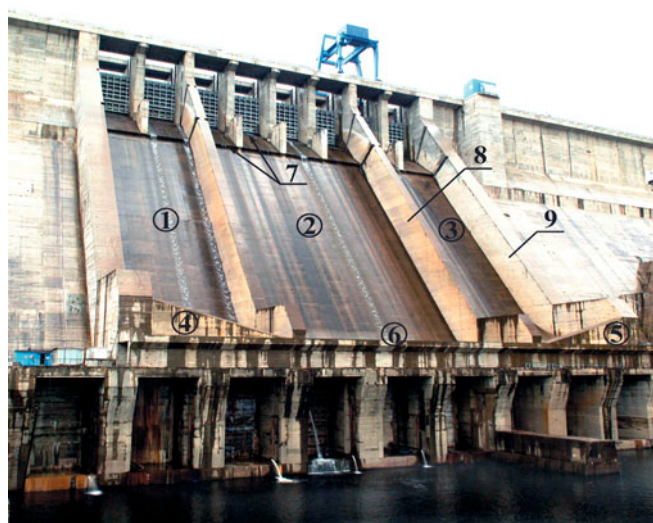
Рис. 1. Общий вид с нижнего бьефа на водосбросную плотину Бурейского гидроузла: 1 — правобережная часть с пролётами № 1 – 2; 2 — центральная часть с пролётами № 3 – 6; левобережная часть с пролётами № 7 – 8; 4, 5 — трамплины-виражи; 6 — цилиндрический трамплин с углом схода 37°; 7 — уступы-азараторы на отм. 237,60 м и 228,80 м; 8, 9 — разделительные и ограждающие стены
