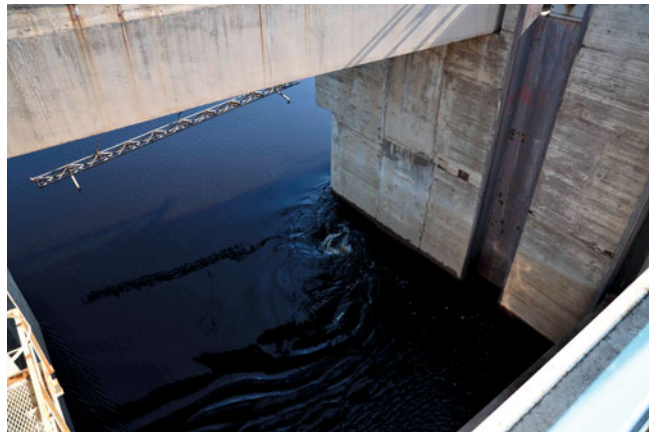
Рис. 8. Режим течения перед затвором № 6 с образованием воздушных воронок при открытии его на 1,5 м в период проведения испытаний в 2021 г.; отм. УВБ = 255,35 м
