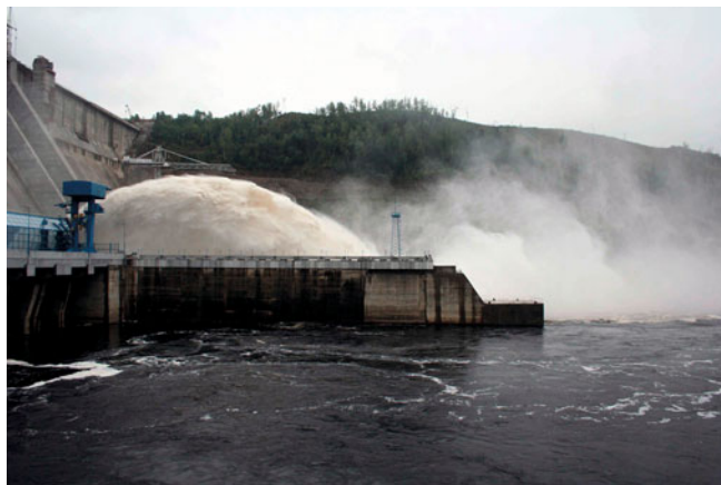
Рис. 6. Дальность отлёта струи при работе пролёта № 3 с открытием его затвора на: а) 1,5 м (2021 г.) и б) 3 м (2009 г.)
