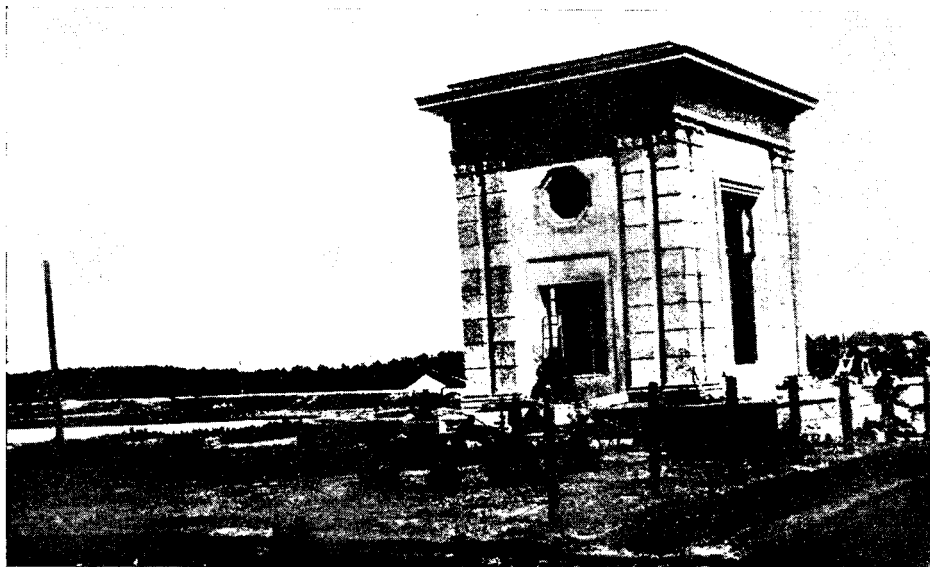
42. Водопроводный канал. Переключатель.
