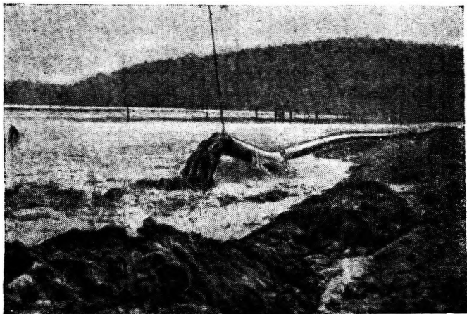
Рис. 23. Укорачивание трубопровода при беззастадном намыве дамбы Квеббин.
